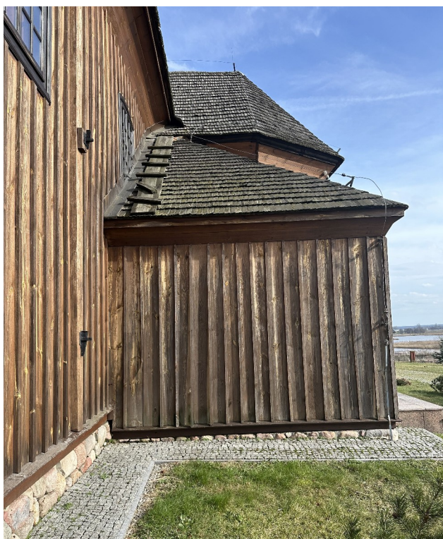
fot. 4: Elewacja boczna kruchty wejściowej z widocznymi zszarzałymi deskami szalunkowymi.
