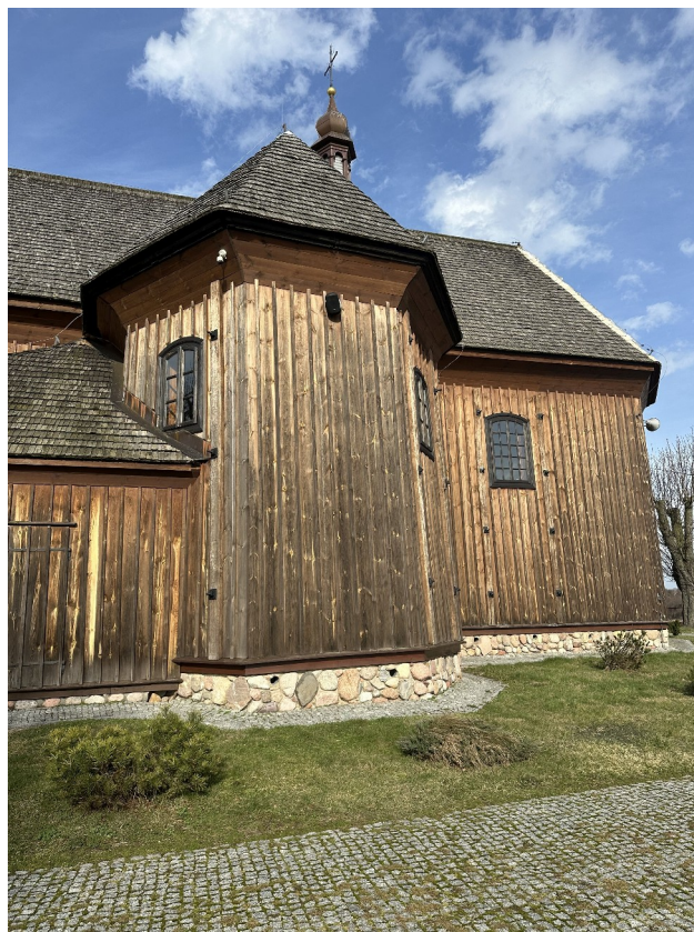
fot. 3: Zszarzałe deskowanie szalunkowe elewacji.
