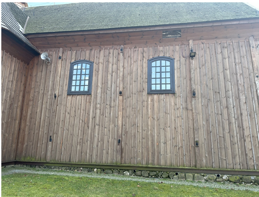
fot. 8: Fragment elewacji północnej z widocznym nalotem biologicznym w dolnej partii elewacji.
