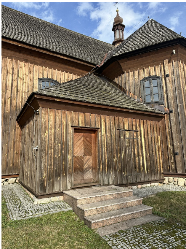
fot. 2: Widoczne zszarzałe deskowanie szalunkowe elewacji.
