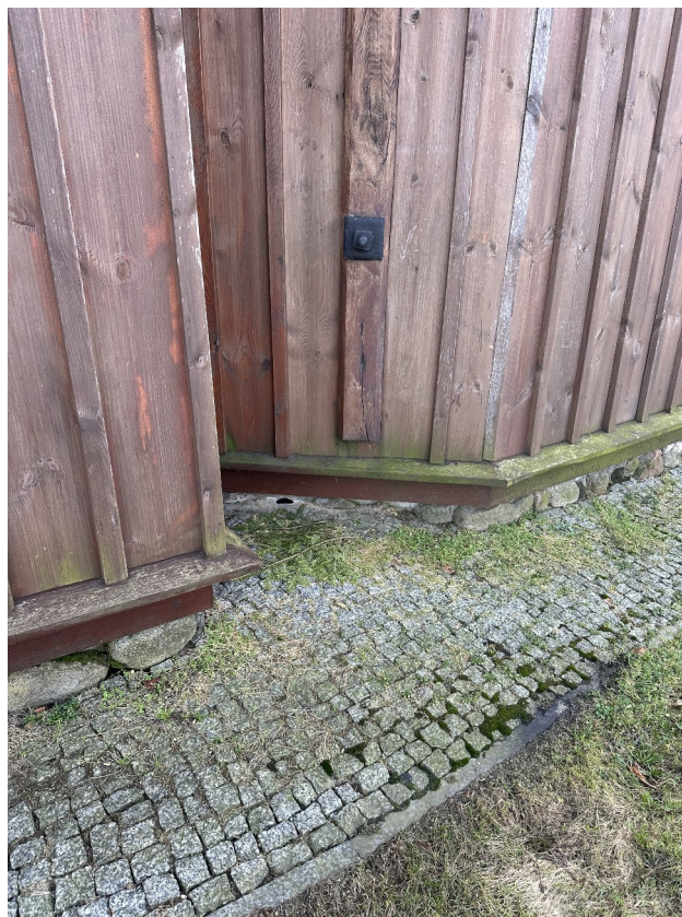
fot. 7: Widoczne wykwyty glonów na deskach szalunkowych i desce okapowej nad cokołem kamiennym.
